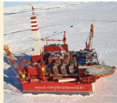
Plateforme offshore de Prirazlomnaya, 2015.
