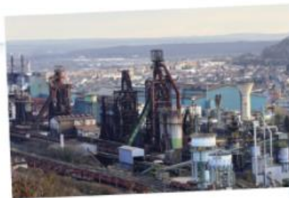
1 L'usine sidérurgique fermée de Florange (Moselle), 2013
